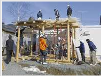
被災した地元大工も協力した作業のようす
